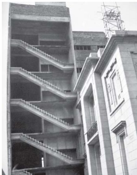
Las obras en marcha, 1967.
