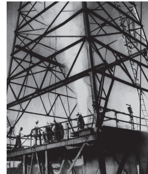
Torre Petrolera, en la provincia de Salta.
